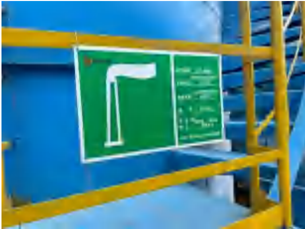
连铸废气、钢包维修废气、火焰切割废气、 上料废气排气筒标识（DA063）
