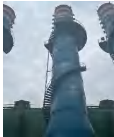
连铸废气、钢包维修废气、火焰切割废气、上料废气排气筒（DA063）
