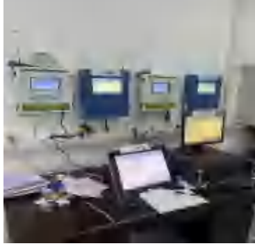
图 4.1-3 在线 CEMS 监测系统
