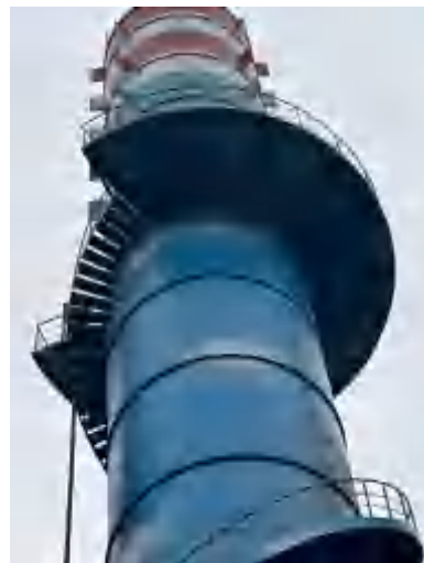
连铸废气、钢包维修废气、火焰切割废气、上料废气采样平台（DA063）
