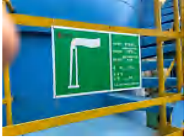
精炼、真空脱气废气排气筒标（DA062）
