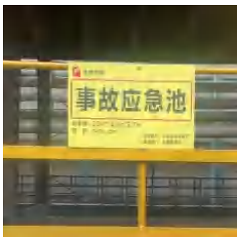
图 4.2-1 厂区事故应急池照片
